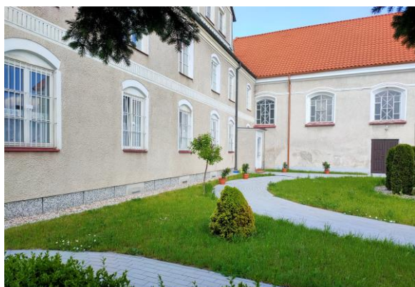
PO ZAKOŃCZENIU PRAC BUDOWLANYCH
